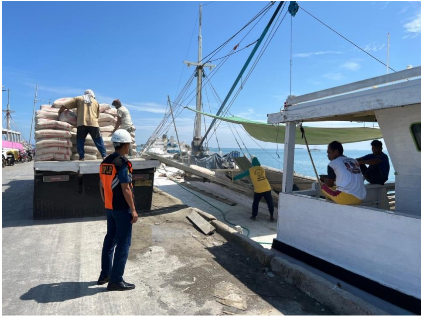
Gambar 4.4 Proses Pemuatan Packing Bag Cement di Pelabuhan Rakyat Maccini Baji, 2024
