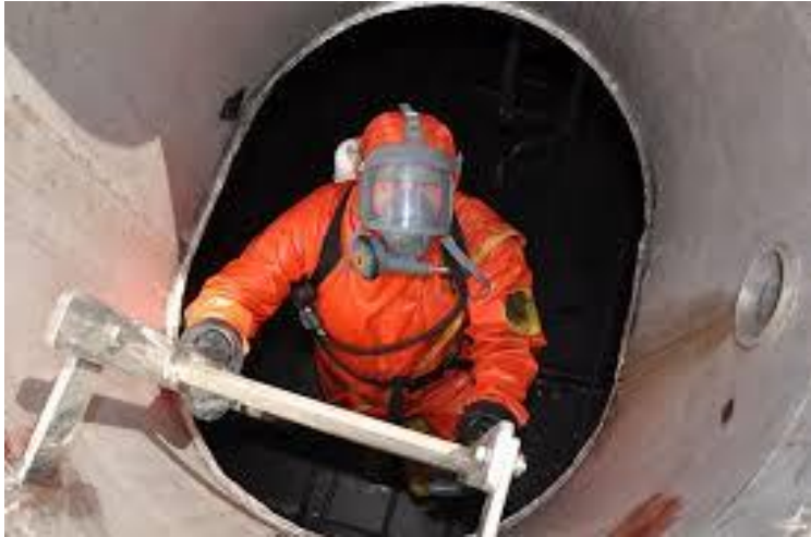
Gambar 6.6 Proses Pekerjaan Dalam Ruang Tertutup ( enclosed spaces )
